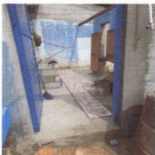
Foto 11: Sustrucción de piso cerámico e instalación de azulejo
