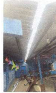
Foto 2: Sustrucción de canal y sustitución de bajada de agua pluvial de metal por tubo 3"
