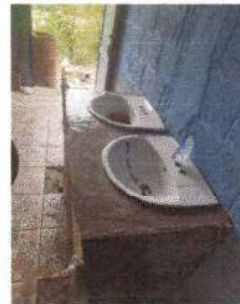
Foto 8: Sustrucción de lavamanos
