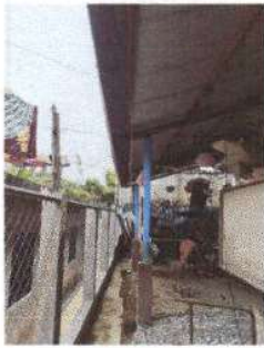
Foto 1: Sustrucción de canal y sustitución de bajada de agua pluvial de metal por tubo pvc 3"
