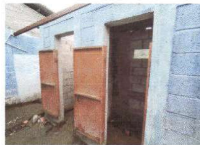
Foto 6: Mantenimiento a estructura (lijado, cambio de tubo, cepillado, sujeciones, aplicación de pintura) a puertas servicios sanitarios
