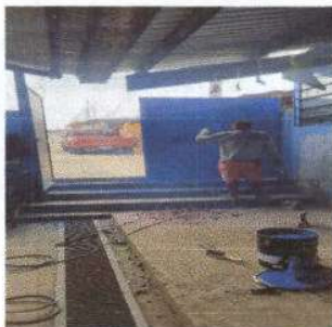
Foto13: Sustitución de portón de metal
