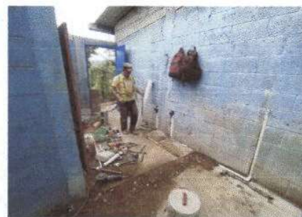
Foto 12: Sustrucción de pila de cemento
